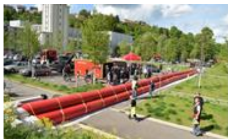
Abb. 7. Mobiles Schlauchwehr schützt Kurzzeitparkplatz.
