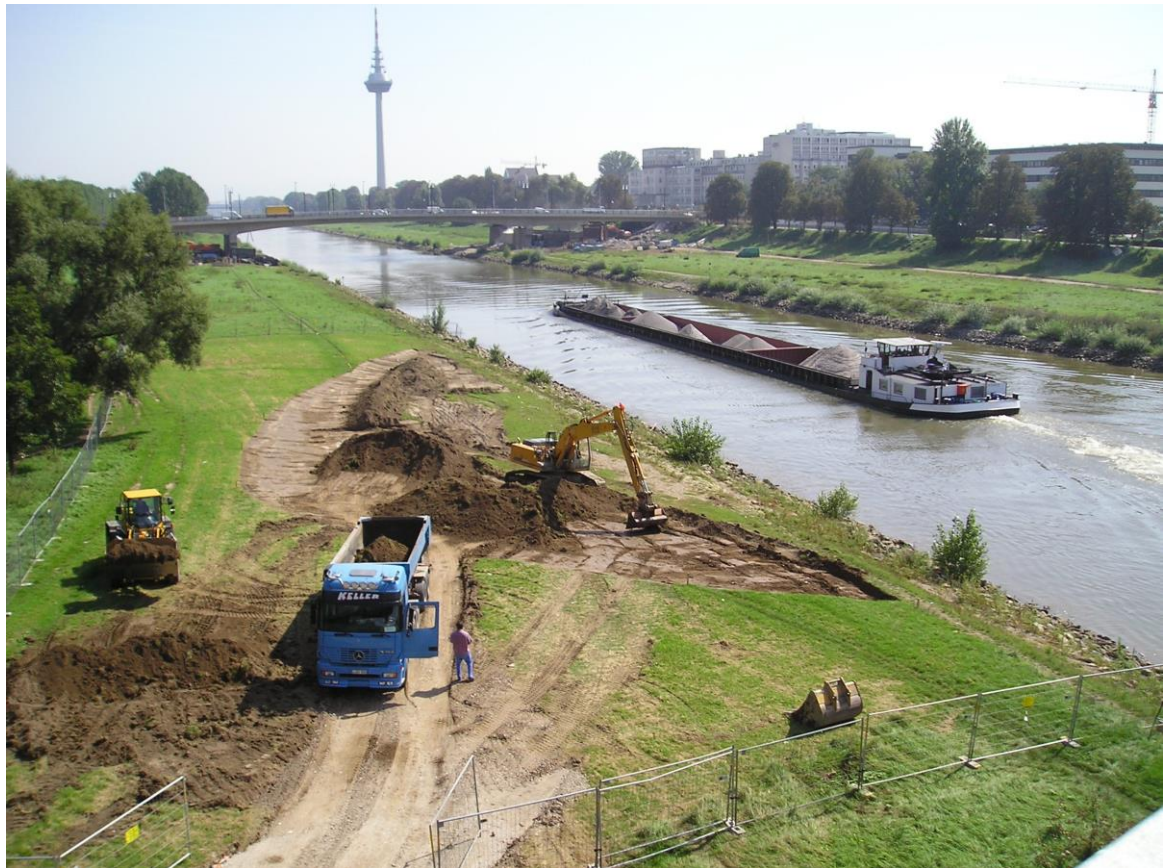
Abb. 20. Baubeginn der Flachwasserzone in Mannheim.
