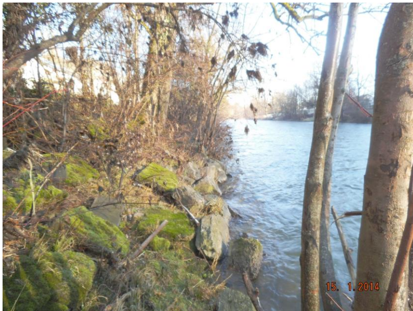
Abb. 29. Massive Böschungssicherung vor Umsetzungen der Maßnahmen.
