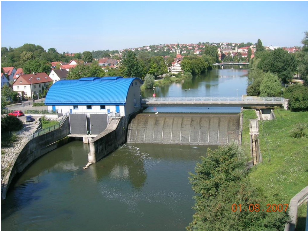
Abb. 23. Flusskraftwerk „Tübinger Straße“ von unten.
