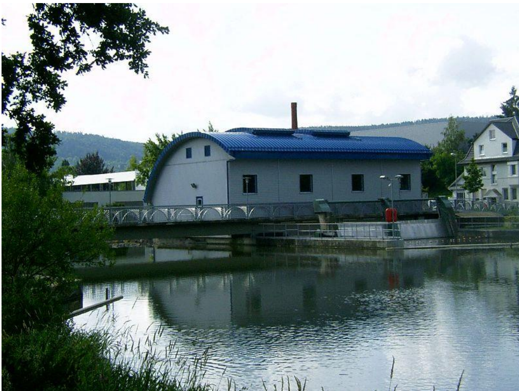
Abb. 24. Flusskraftwerk „Tübinger Straße“ von oben.
