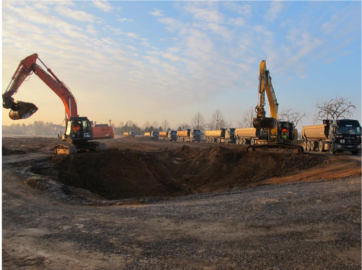
Abb. 18. Baubeginn der Fischkinderstube Edingen-Neckarhausen – hier am 16. Februar 2017.
