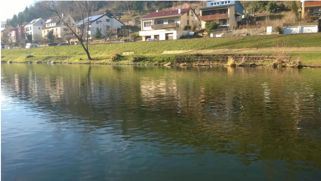
Abb. 31. Ingenieurbiologische Böschungssicherung nach Umsetzung der Maßnahmen.
