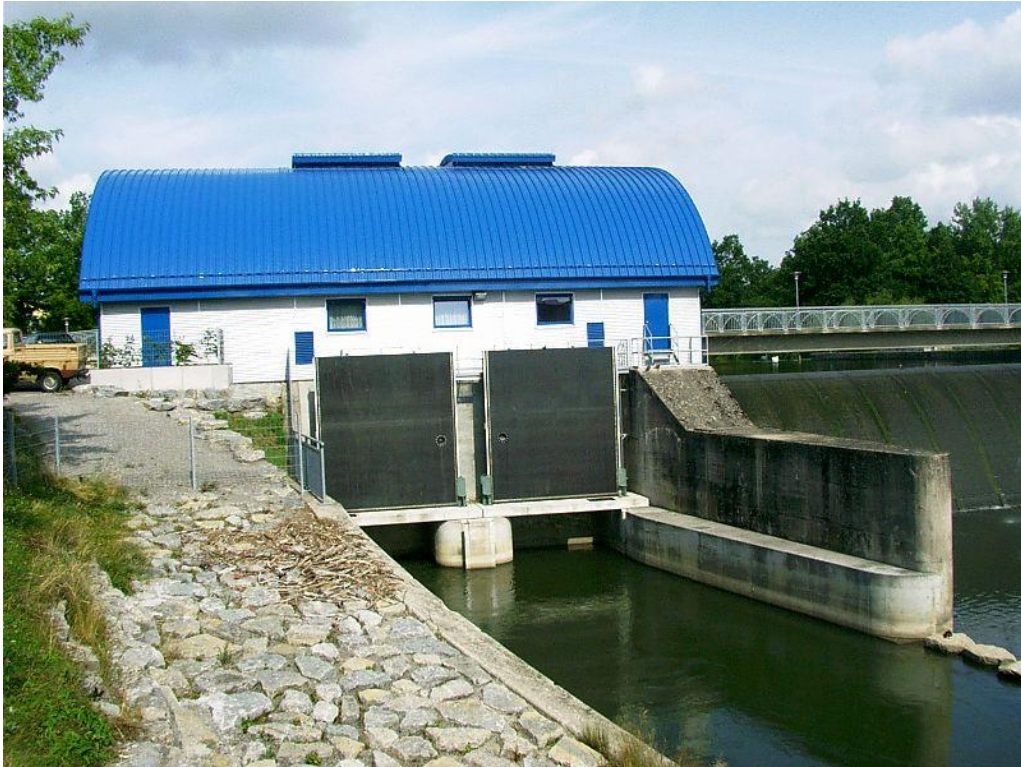
Abb. 27. Kraftwerk „Tübinger Straße“ von unten.
