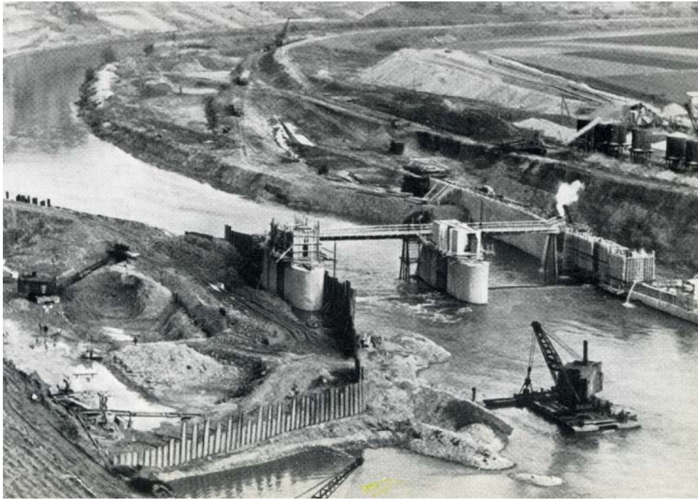
Abb. 24: Bau der Staustufe Poppenweiler in den Jahren 1952-1958
