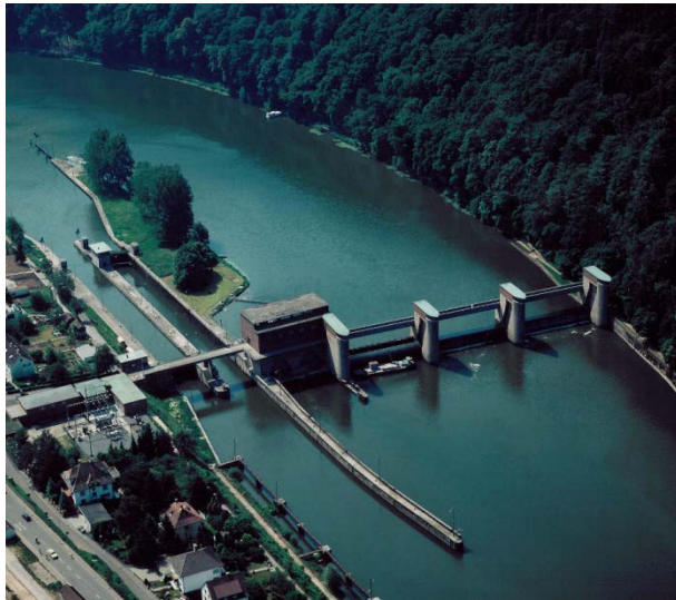
Abb. 35: Staustufe Neckarsteinach mit Schleuse, Kraftwerk und Wehr (von links nach rechts)
